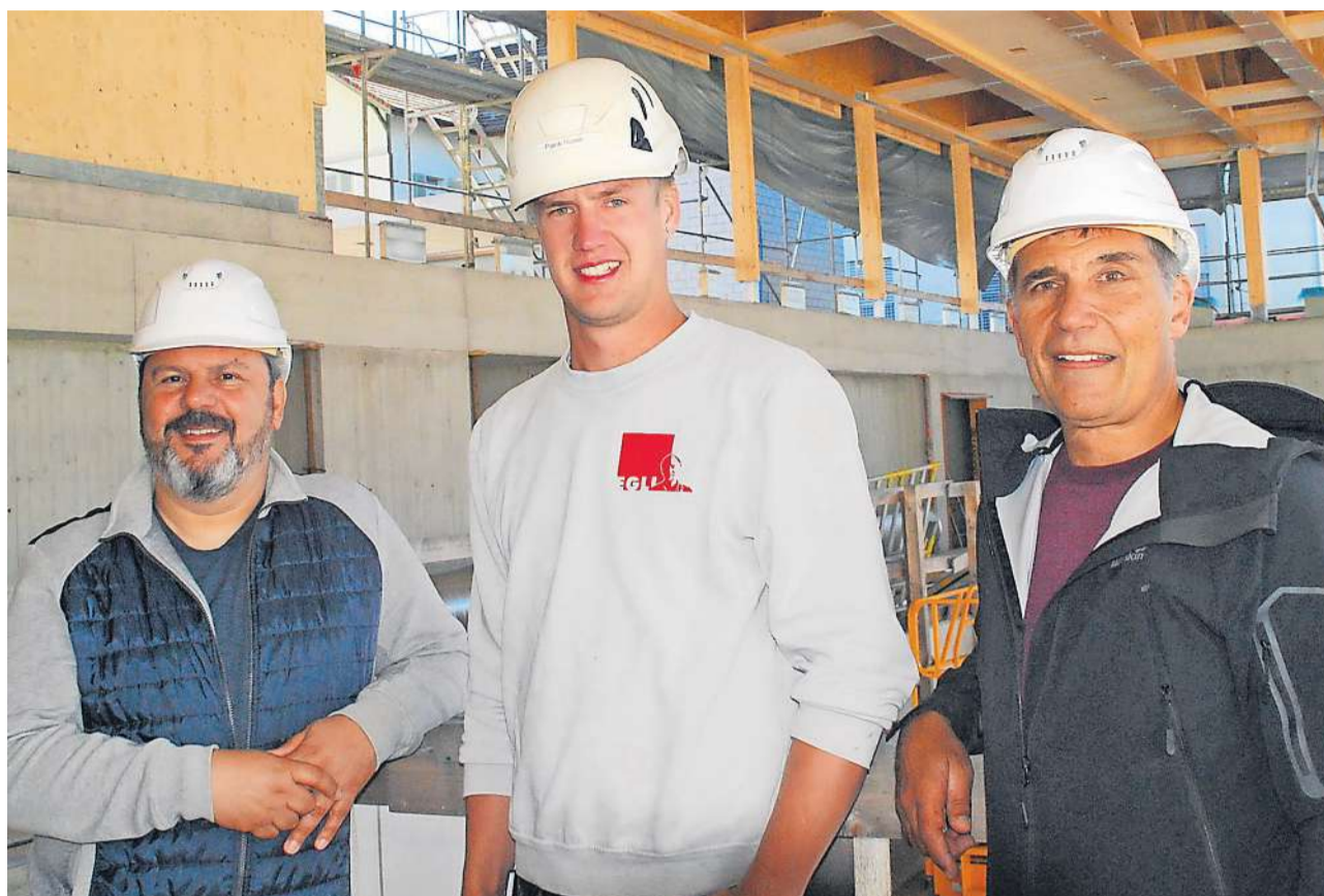
Nicola Maimone, Patrik Huser und Ruedi Wolfender führten durch die Baustelle.
